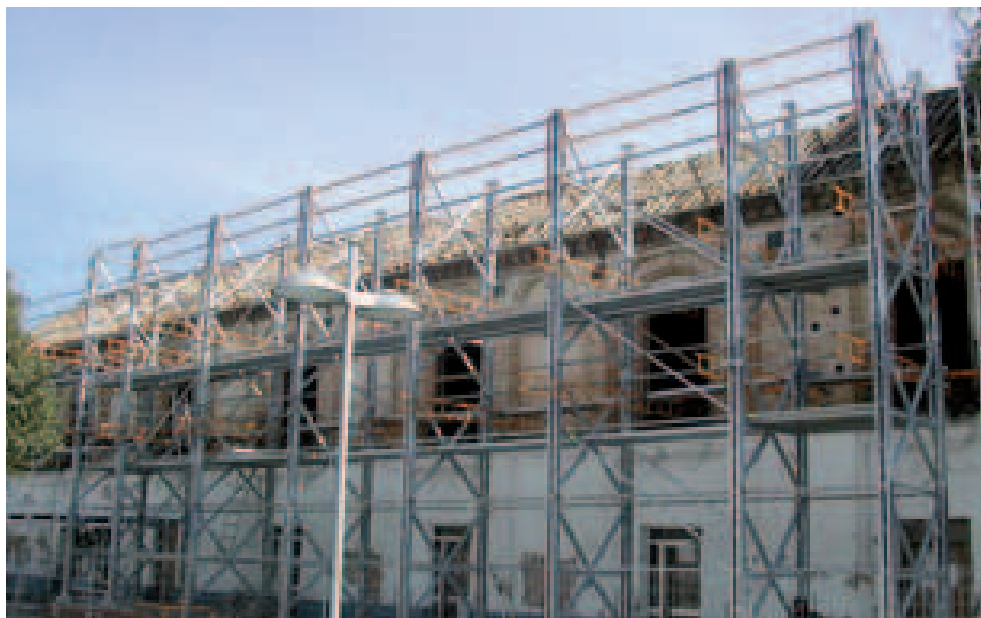
Estabilización de fachadas frente a cargas horizontales
