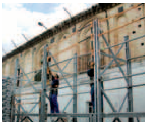
Estabilización de fachada mediante torres independientes y encadenadas
